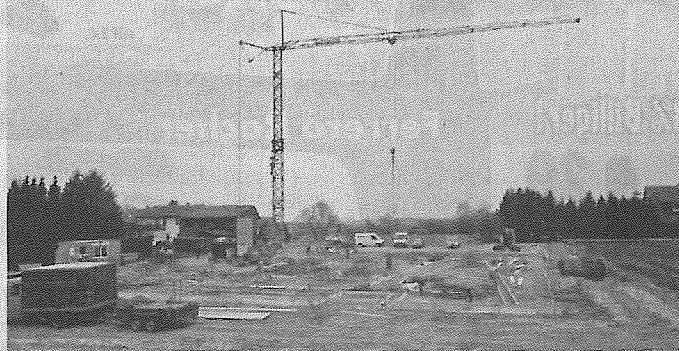
Baubeginn: Gut 5.000 Quadratmeter groß ist das Grundstück am Drosselweg in Hüllhorst. Es liegt nicht weit vom Zentrum entfernt.
