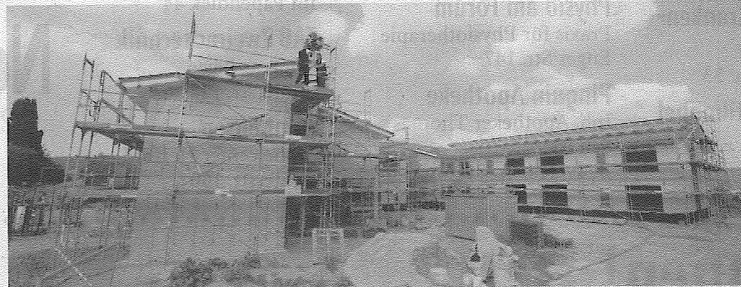
Halbfertig: Über dem Neubau in Hüllhorst am Drosselweg 28 weht der Richtkranz. Das Foto verdeutlicht die Hufeisenform des Gebäudekomplexes.
