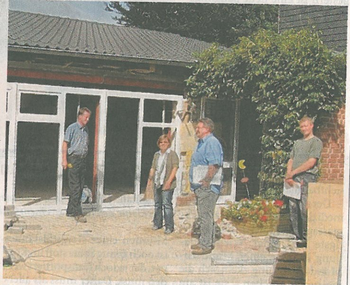
Umbau geht voran: Siegrid Kittel (Leiterin der Kita) und Architekt Andreas Krauß besprechen die nächsten Maßnahmen. FOTO: LEBENSHILFE
